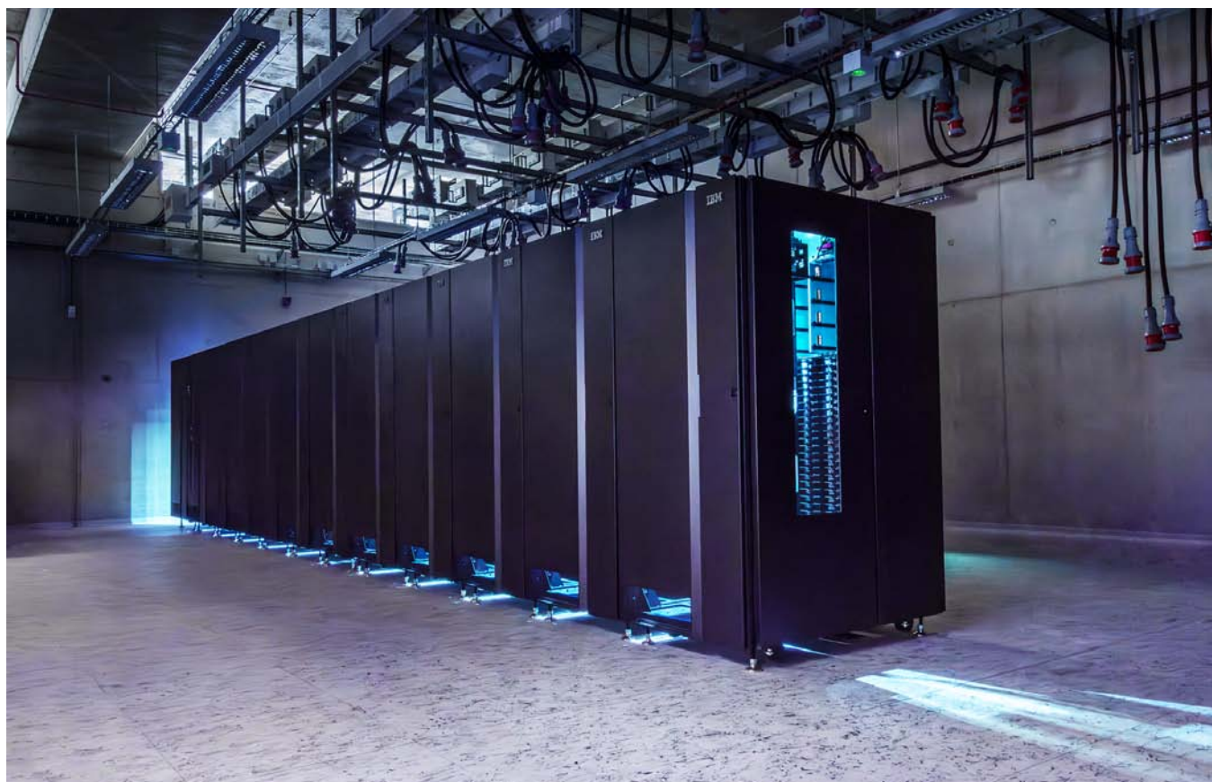
Kiosk z nośnikami danych
